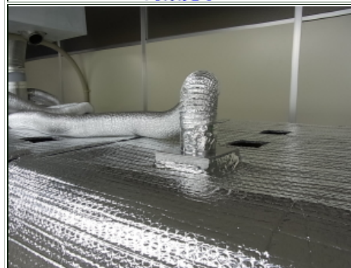
ダクト取付け
